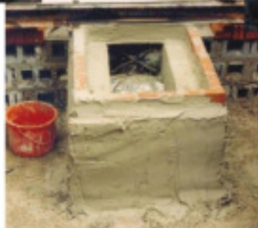
Le foyer décalé (en dessous de la sole) pour gueulard
