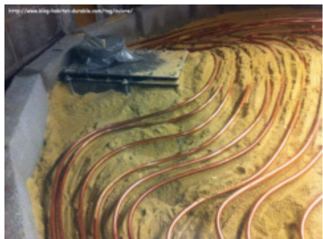
Système de récupération de la chaleur des fours (Ferme de la Croix -B)
