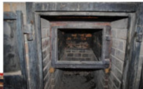
Le foyer décalé (en dessous de la sole) pour gueulard
