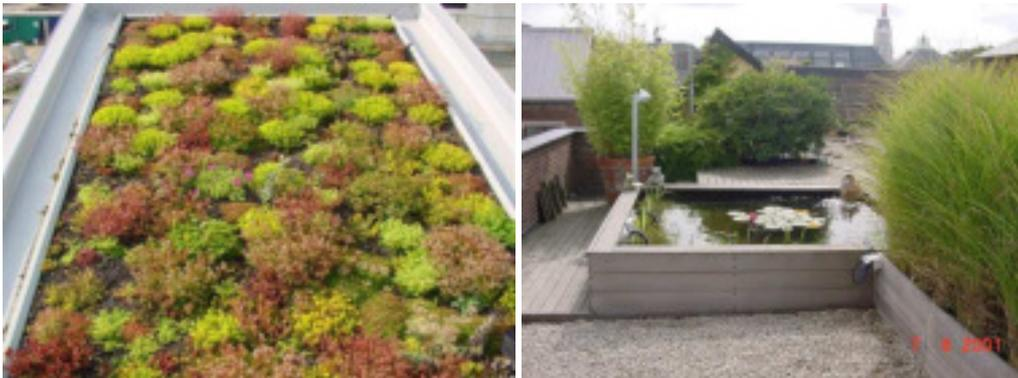
Une toiture verte extensive et intensive (Sources: ekogras et construmat)
