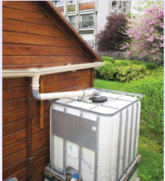
Petit récupérateur d'eau de pluie, largement suffisant pour assurer l'arrosage des espaces verts de l'immeuble
