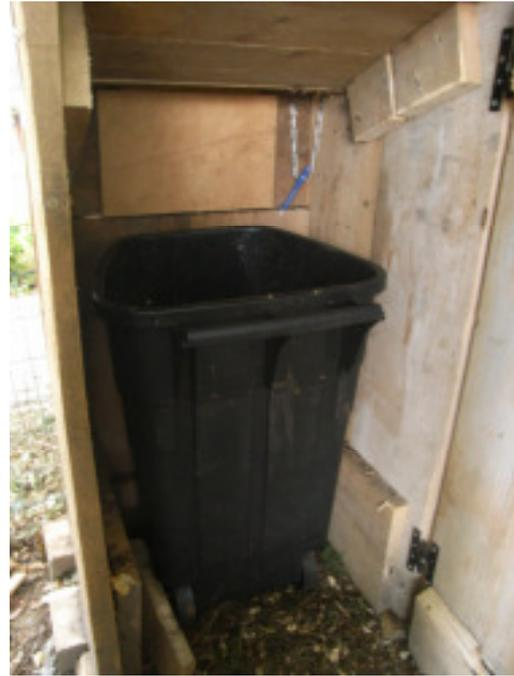
*La collecte se fait par l'arrière de la poubelle-compostière. Une porte permet l'accès à une poubelle sur roues de 110L.*
